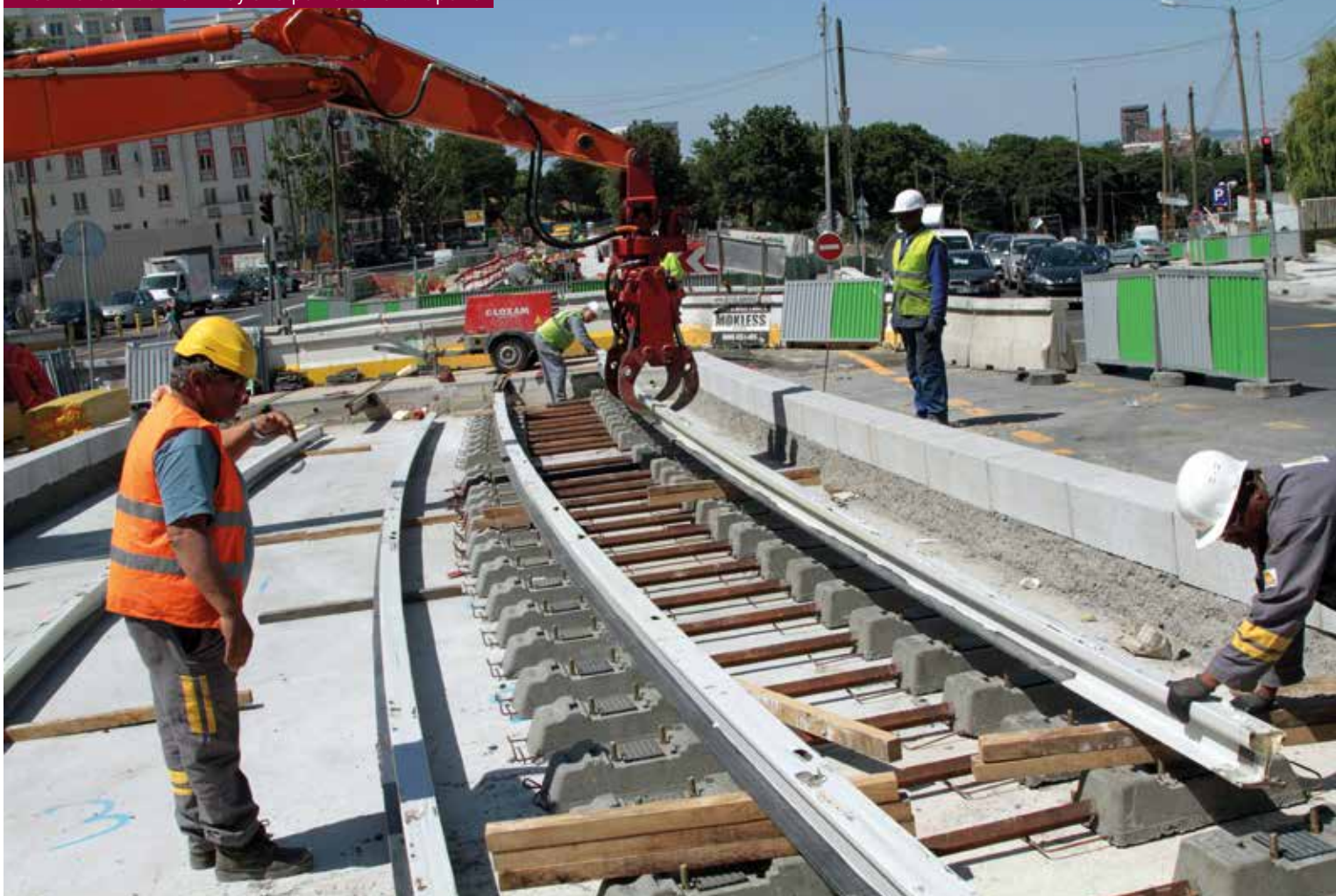
Les travaux du tramway à la porte de la Chapelle
